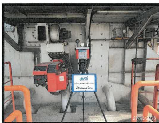
ภาพที่ 4.2.4-1 การตรวจวัดระดับความร้อนในการทำงาน
